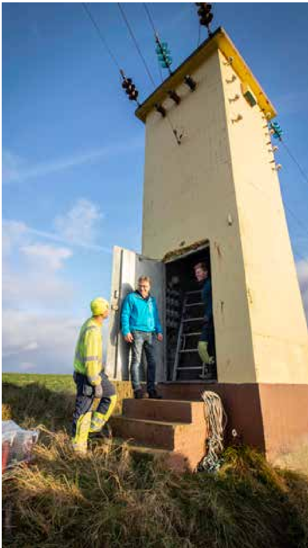
Direktør i Klepp Energi, Håkon Ådland slår av en prat med lærling Morten Sætre og montør Per Harry Saurdal som her skifter en gammel bryter i en tårnkiosk på Reve.
