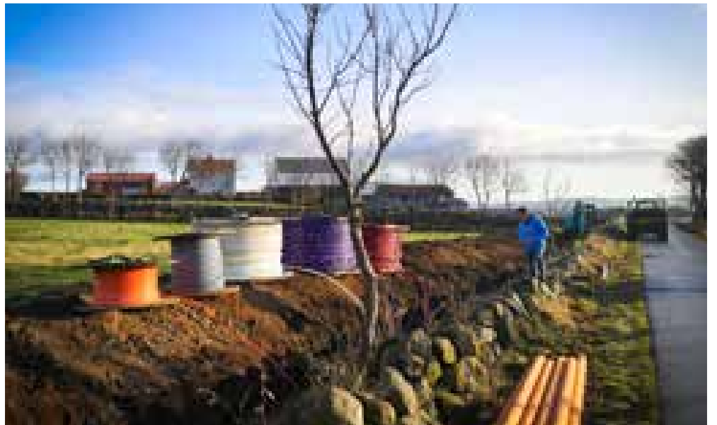
På Salte er Klepp Energi i full gang med å føre bredbånd fram til de siste husstandene i Klepp.
